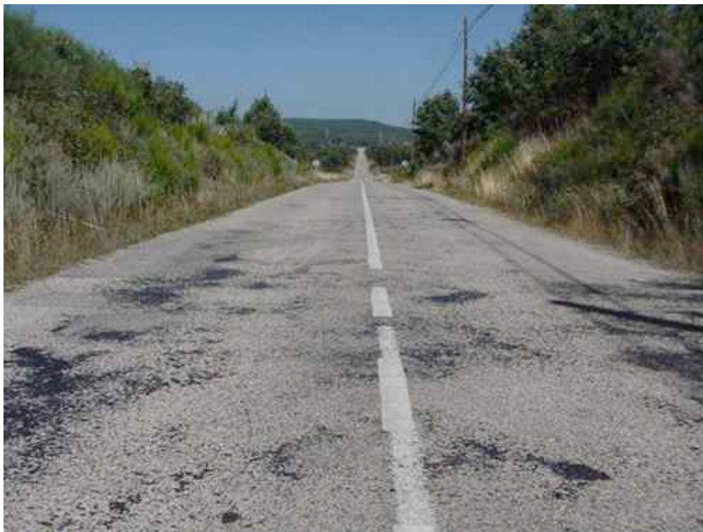
Imagen antes de las obras
