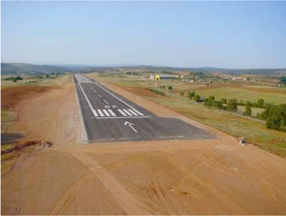
Imagen de las obras finalizadas
