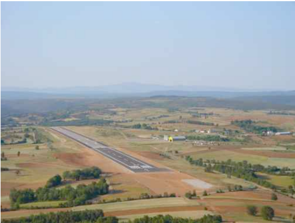
Imagen de las obras finalizadas
