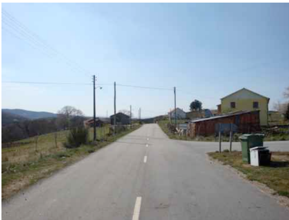
Imagen de las obras finalizadas
