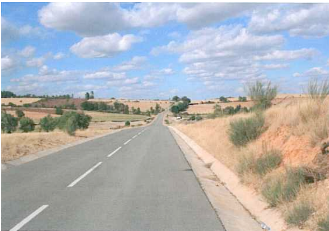
Imagen de las obras finalizadas
