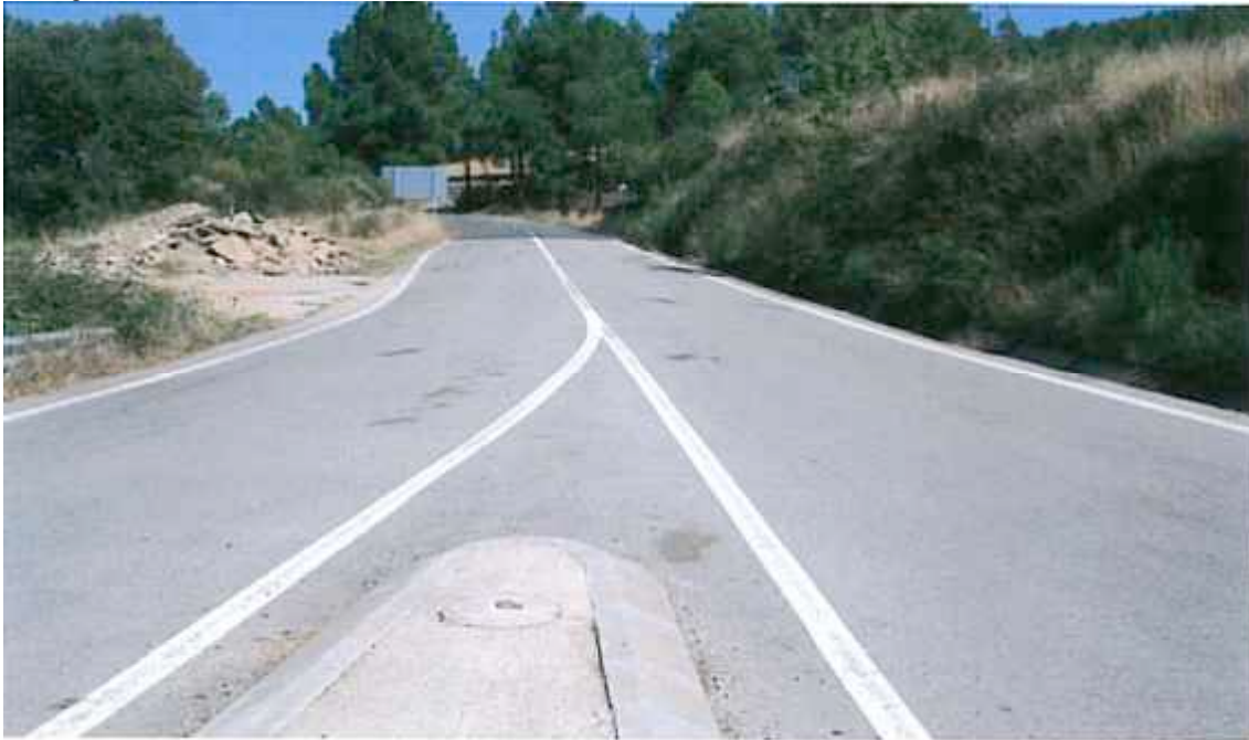
Imagen de las obras finalizadas
