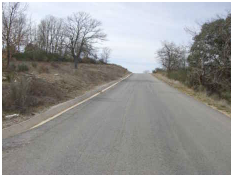
Imagen de las obras finalizadas
