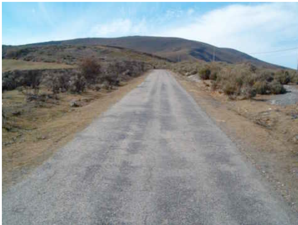
Imagen antes de las obras
