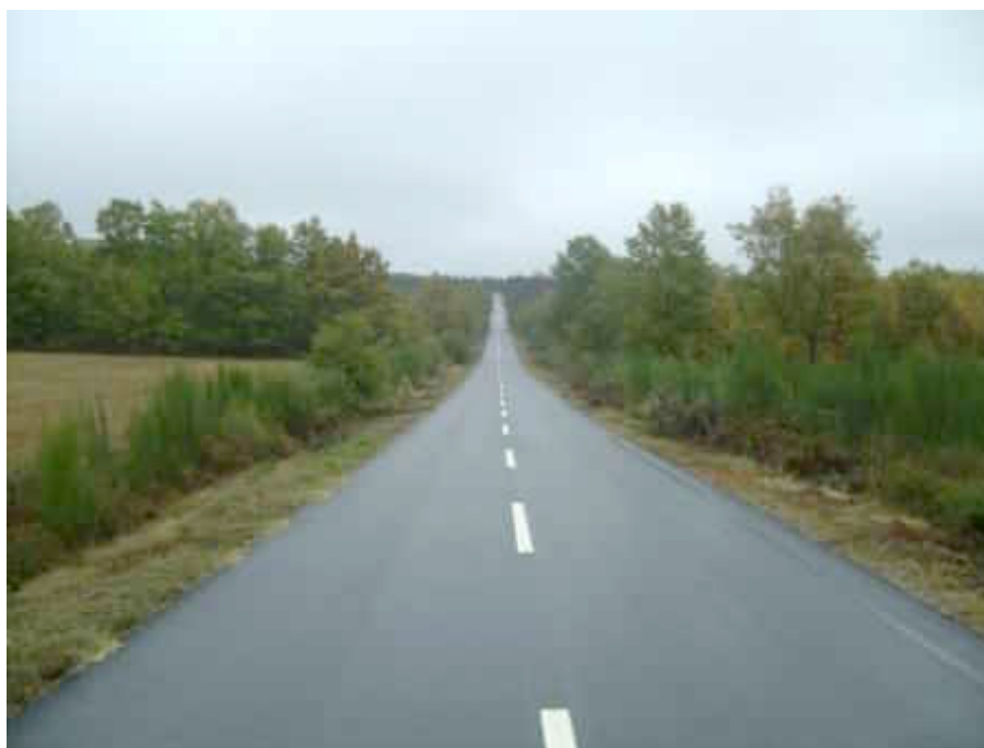
Imagen de las obras finalizadas
