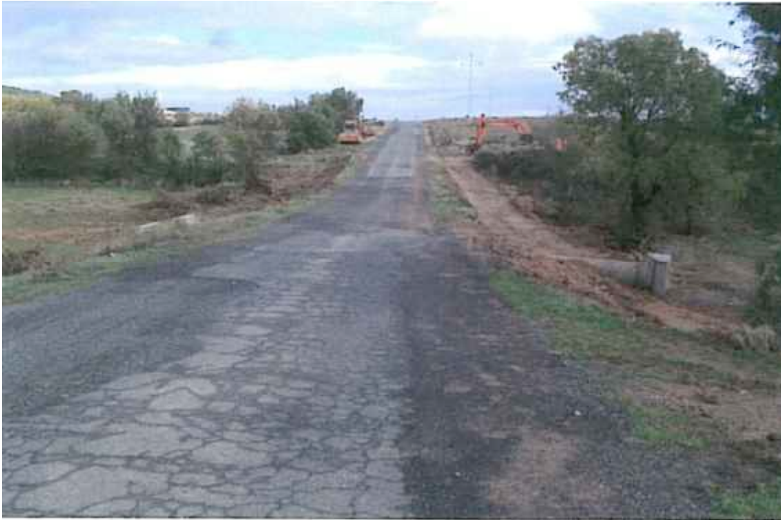
Imagen antes de las obras
