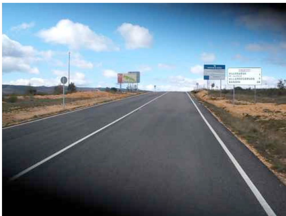
Imagen de las obras finalizadas
