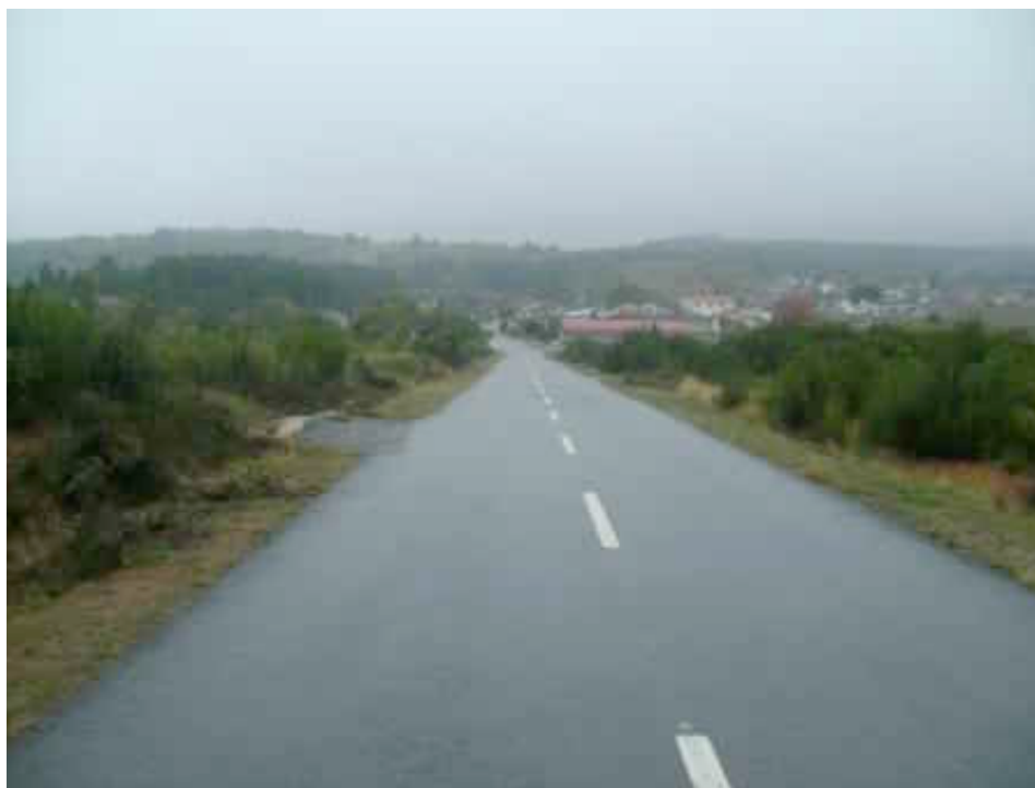
Imagen de las obras finalizadas
