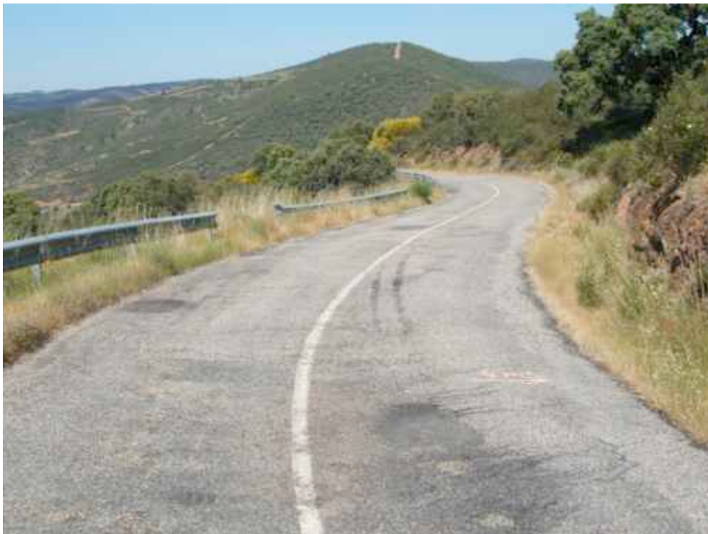
Imagen antes de las obras
