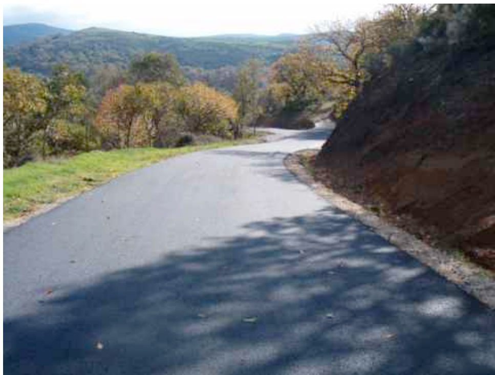
Imagen de las obras finalizadas
