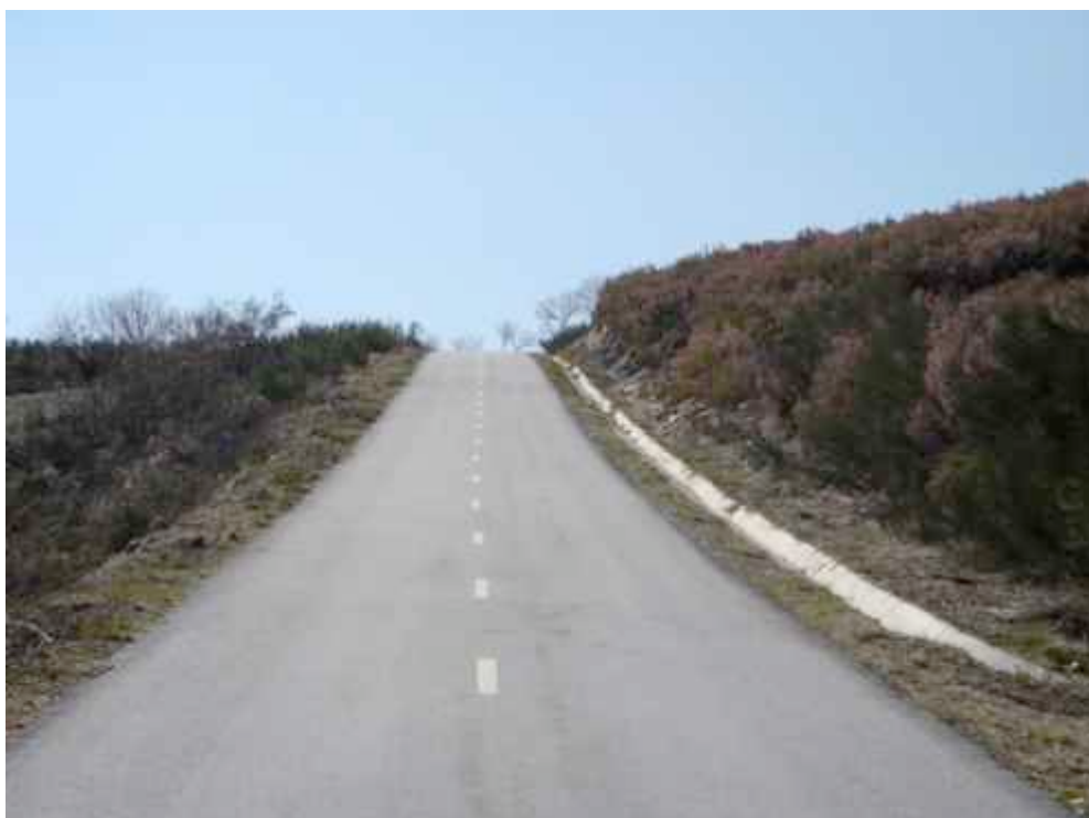
Imagen de las obras finalizadas
