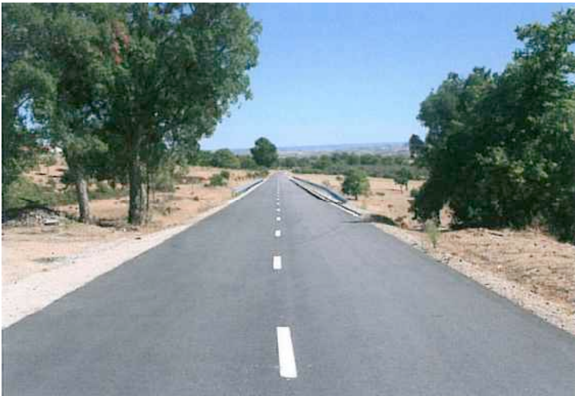
Imagen de las obras finalizadas
